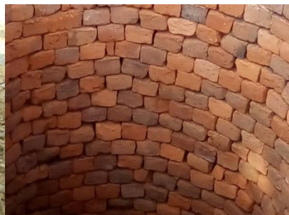
Der Bau der Zisterne für die Toiletten
